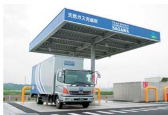
佐川急便豊田店の天然ガス充填所
