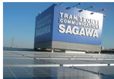
太陽光発電システム
